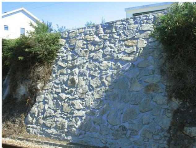
**Figura 2.3 – muro de pedra argamassada.**
