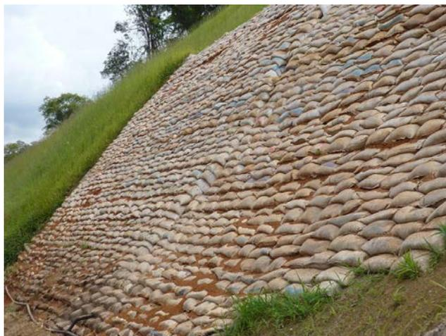
**Figura 2.10 – Muro de solo-cimento.**
