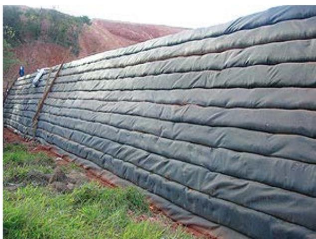
**Figura 2.13 – Aterro reforçado com geotêxtil.**
