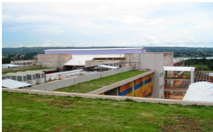
Figura 3.7: Telhado verde do Instituto Federal de Brasília (ECOTELHADO, 2017).
