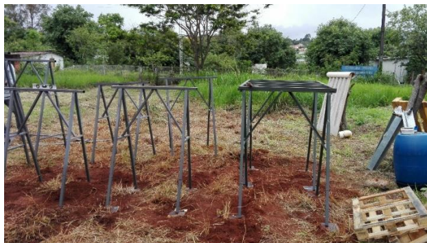
Figura 4.4: Etapa de instalação das unidades piloto, inclinação dos cavaletes (2018).
