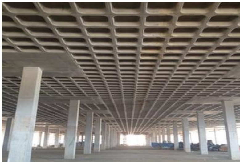
Figura 3: Detalhe da laje nervurada (Fonte: AECWEB, 2018).
