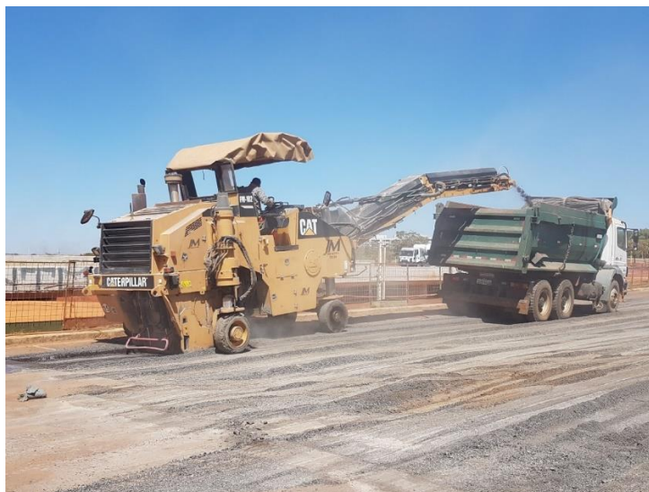
Figura 3-2 Operação de fresagem Trevo de Triagem Norte
