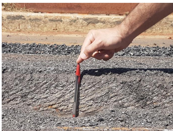
Figura 3-3 Verificação aproximada da espessura de corte
