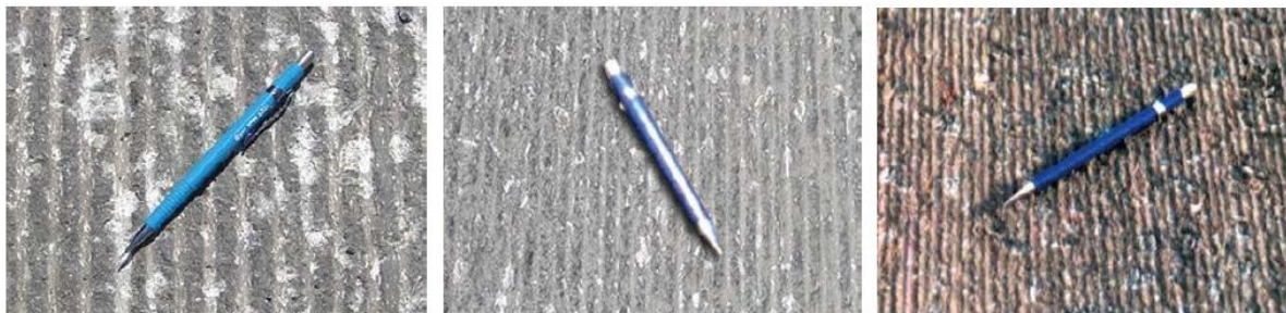
Figura 2-2 Comparação das rugosidades resultantes de diferentes tipos de fresagem. Da esquerda para direita: fresagem padrão, fresagem fina e microfresagem (BONFIM, 2007 – Livro de fresagem)
