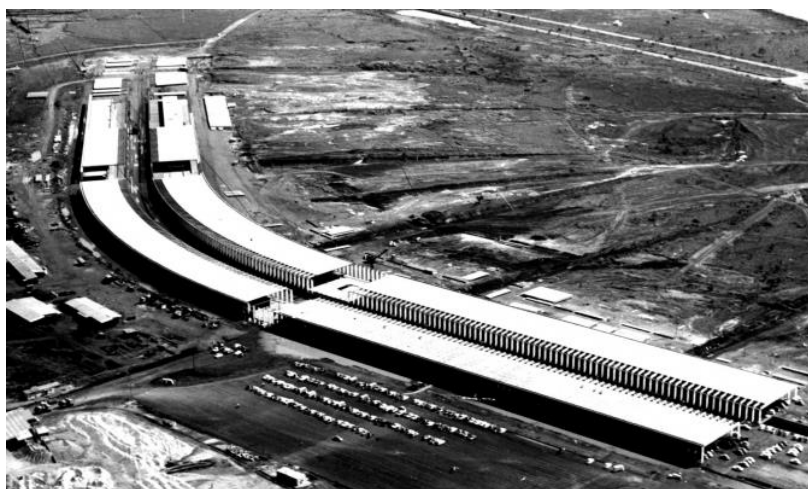
Figura 3.3 – Instituto Central de Ciências (ICC) em 1972 Fonte: UnB Agência (2012)
