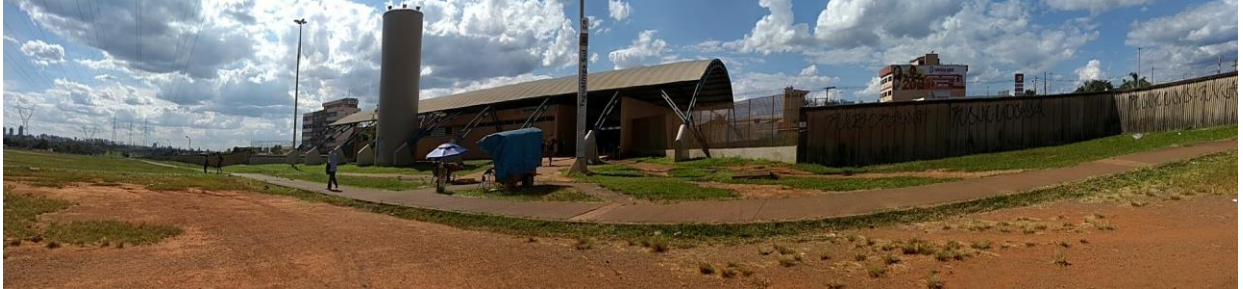
Figura 11: Imagem Estação Taguatinga Sul Fonte: Própria (2018)
