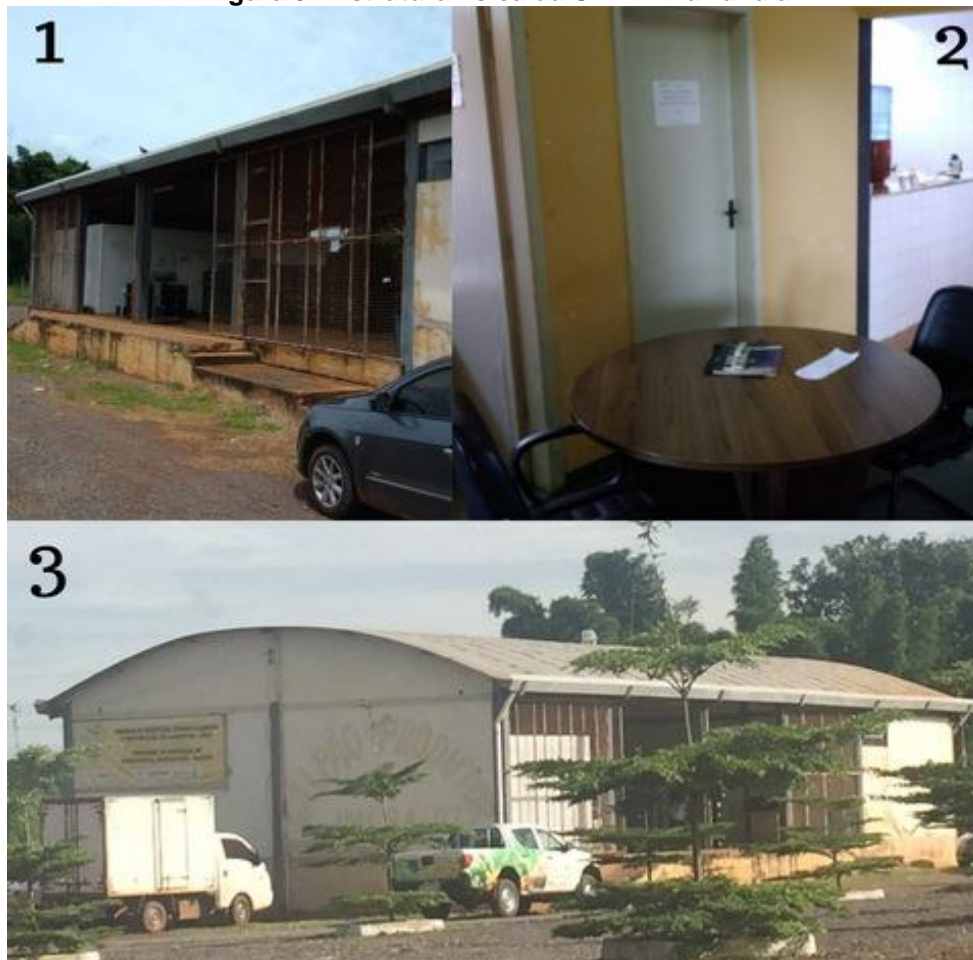
Figura 3 - Estrutura física da URDA Brazlândia
