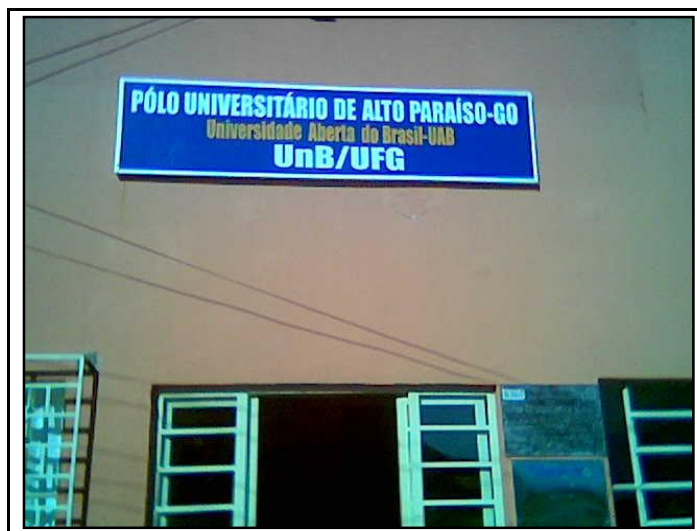
Figura 1 – fachada principal do Pólo de Alto Paraíso
