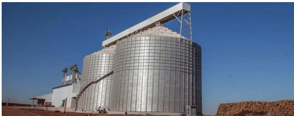
**Figura 2.1** - Exemplo de silos de fundo plano (KEPLER WEBER, 2017).
