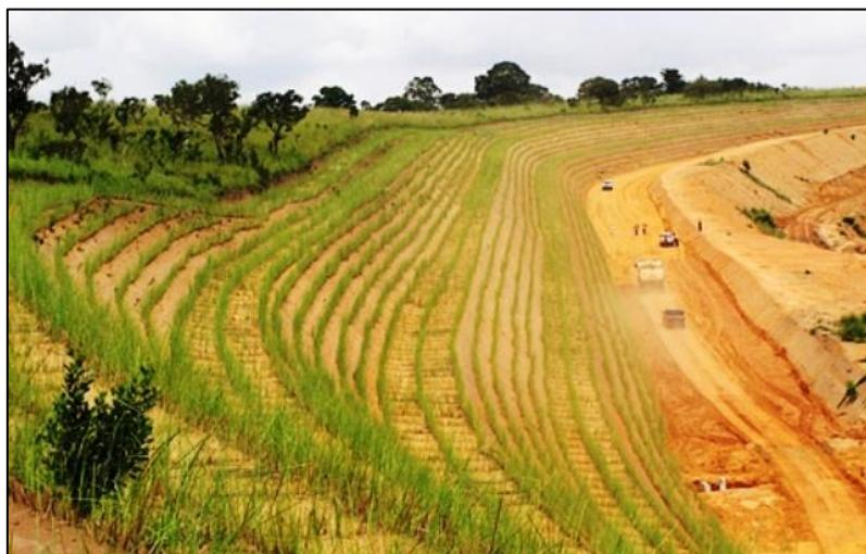
Figura 6.4 - Capim Vetiver plantado em um talude
