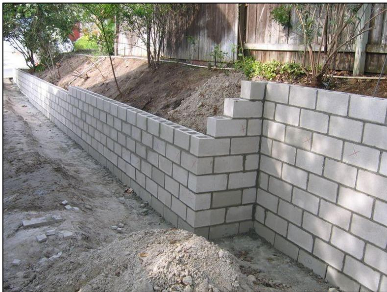
Figura 5.1 - Muro de Arrimo
