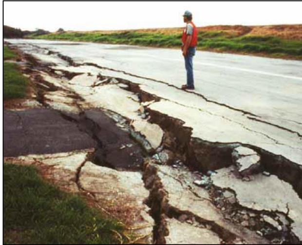
Figura 2.11 - Fotografia de um espalhamento lateral ocorrido em uma rodovia. (Fotografia por Steve Ellen, U.S. Geological Survey).
