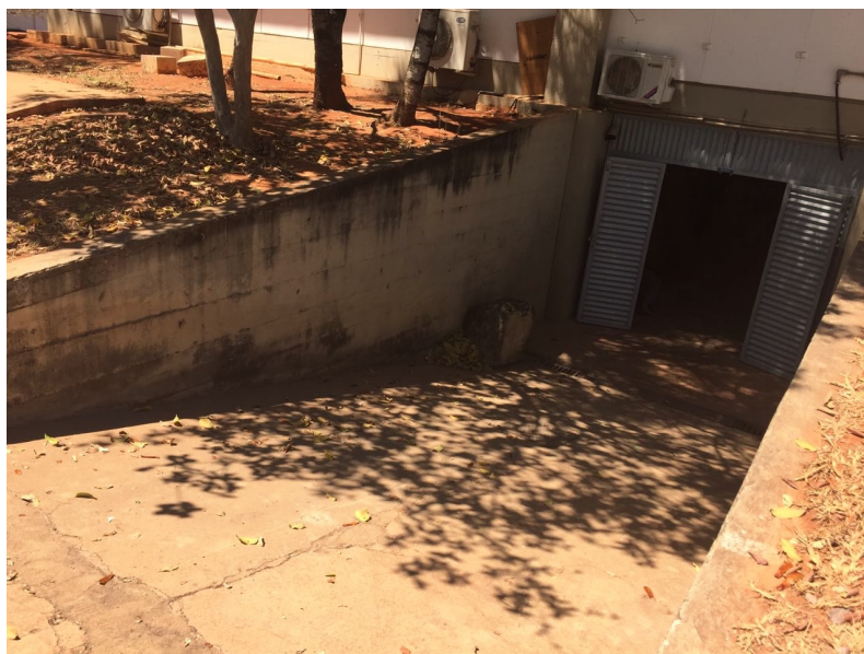
Figura 16 - Fotografia da Rampa de acesso ao subsolo Vargas (2017).
