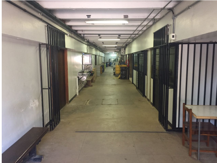
Figura 15 - Corredor Principal subsolo
