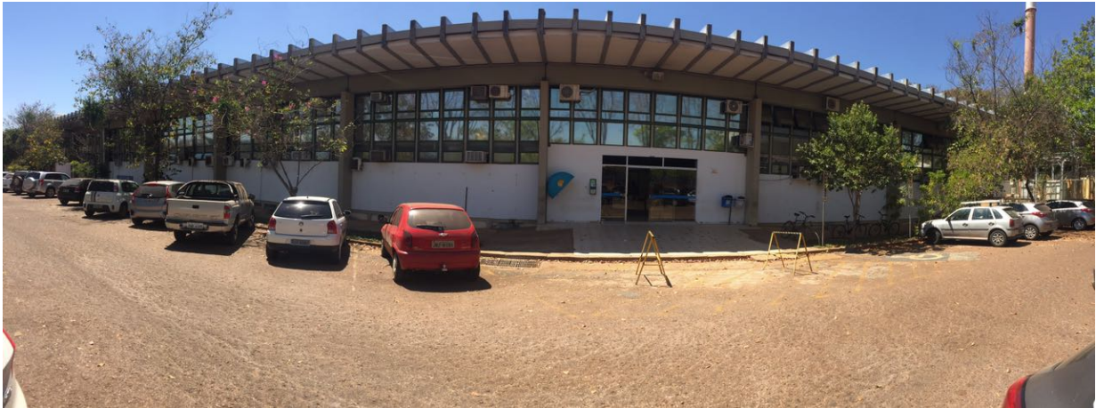
Figura 1 - Fachada frontal do prédio SG-12. (Vargas, 2017)
