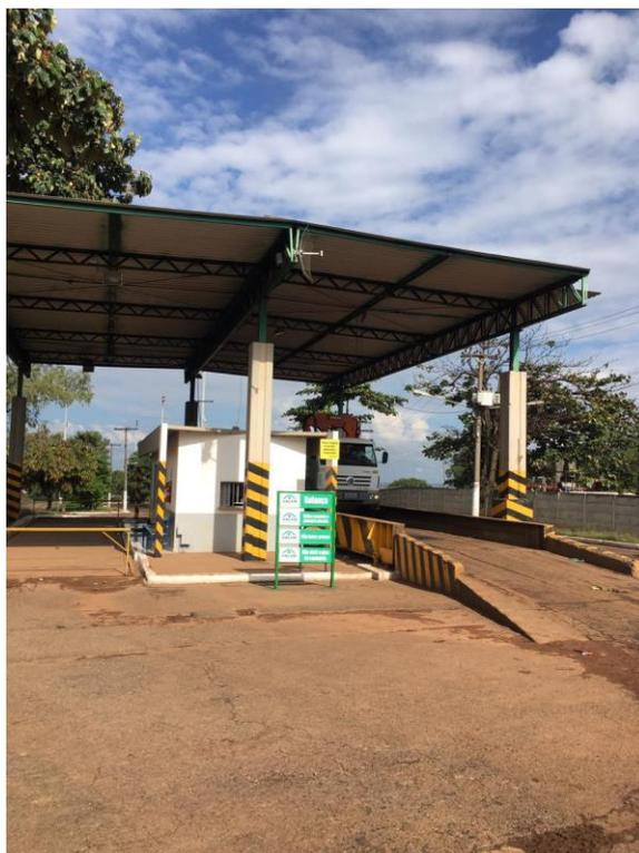
Figura 3 – Balança de pesagem dos caminhões.
