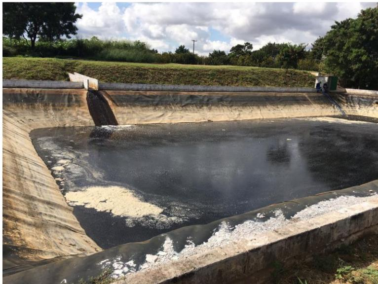
Figura 16 – Exemplo de uma das bacias de contenção de chorume.
