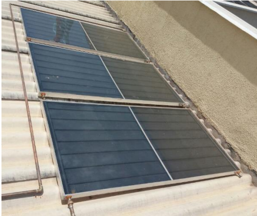
Figura 19. Coletor solar plano fechado
