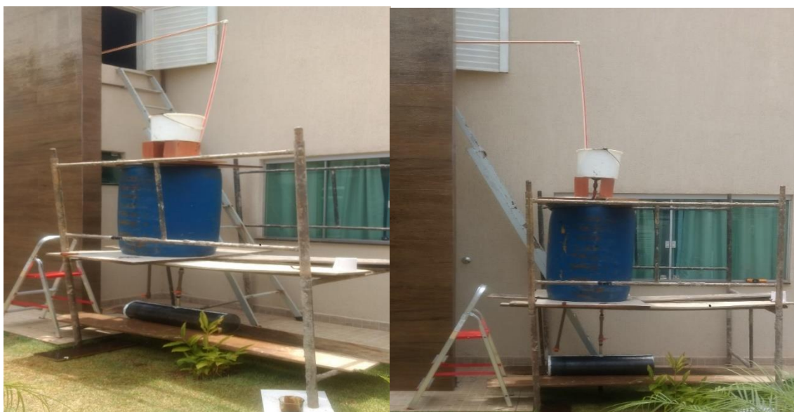
Figura 25. Sistema de aquecimento
