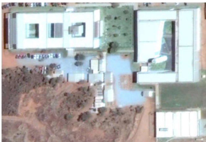
Figura 4 – Univesidade de Brasília - Faculdade Gama
