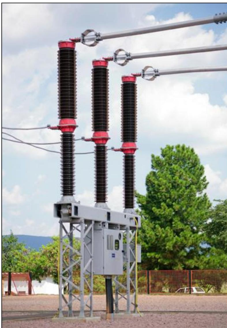
**Figura 9. Disjuntor Siemens 145 kV. [FRONTIN et. al, 2013.]**
