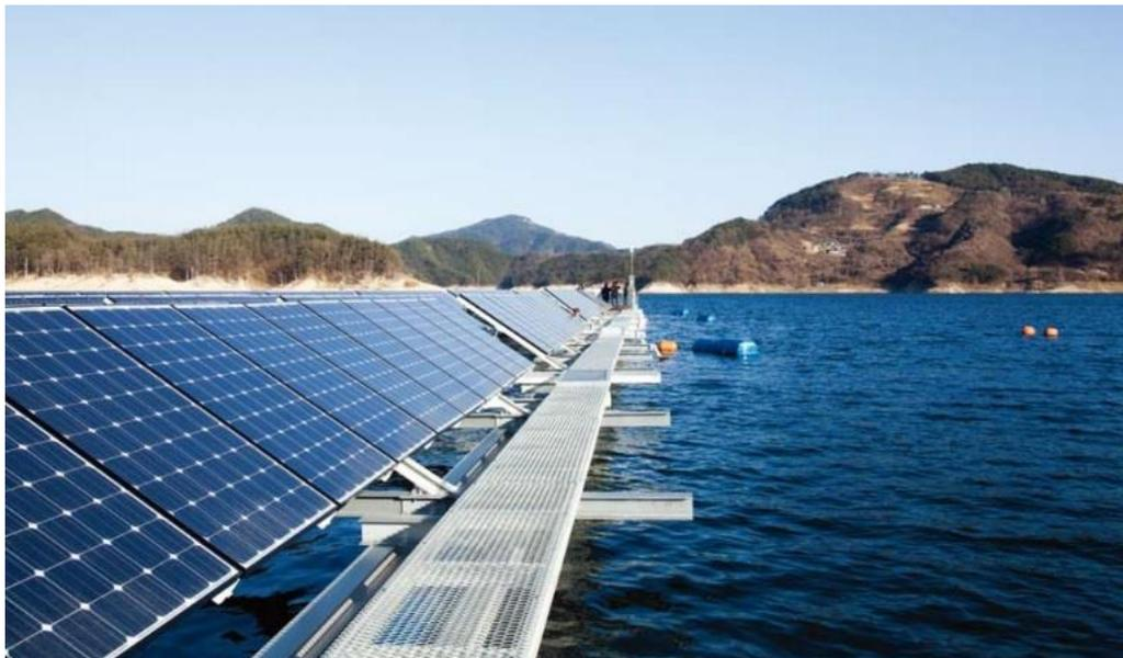
Figura 2 - Sistema fotovoltaico flutuante no reservatório da usina hidrelétrica de Hapcheon (Fonte: K-WATER, 2012).
