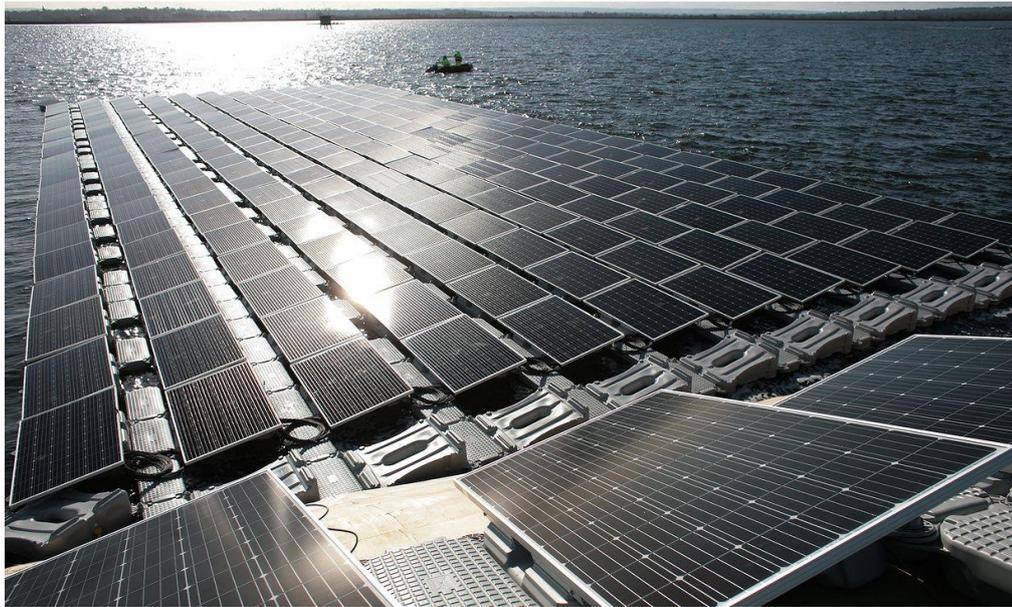
Figura 4 - Sistema fotovoltaico flutuante em construção no Reino Unido (Fonte: THAMES WATER, 2016).
