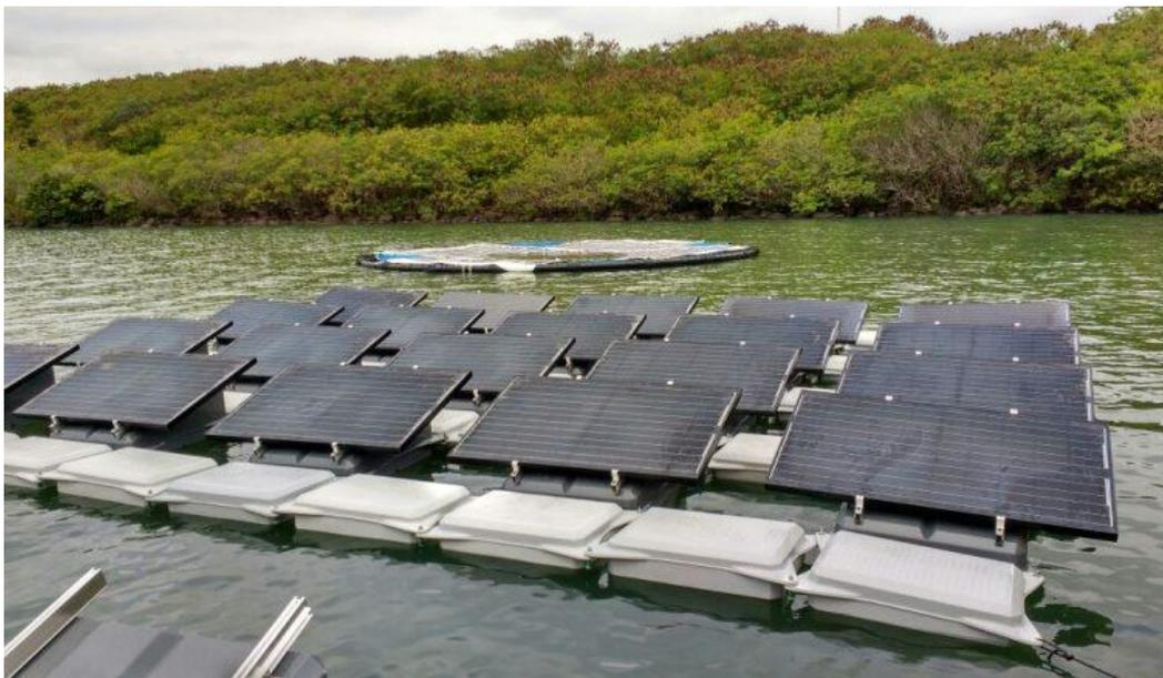
Figura 6 – Sistema fotovoltaico flutuante instalado em Rosana, São Paulo (Fonte: BLUE SOL, 2016).
