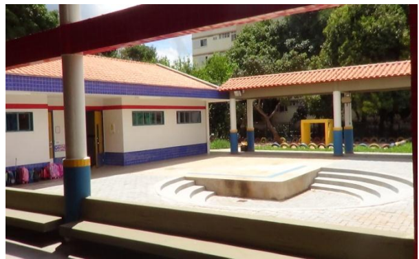
Foto 2 - Creche 1- Área externa
