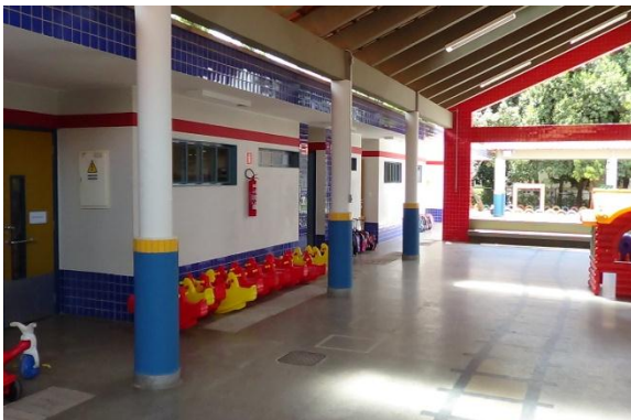
Foto 1 - Creche 1- Área coberta
