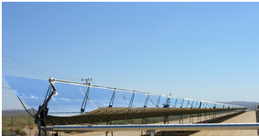
Figura 1.4. Ilustração de uma calha parabólica (Energia Tecsolar, 2015)
