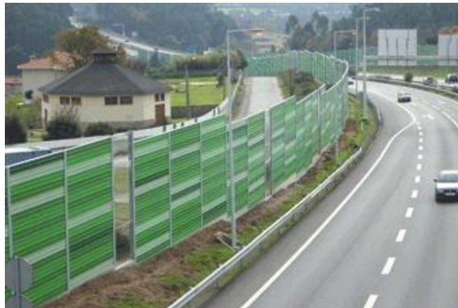
Figura 2 - Barreira acústica em rodovia (Disponível em: http://www.lnz.com.br/arquivosSGC/SERV20090703073007barreira_acust.JPG ).
