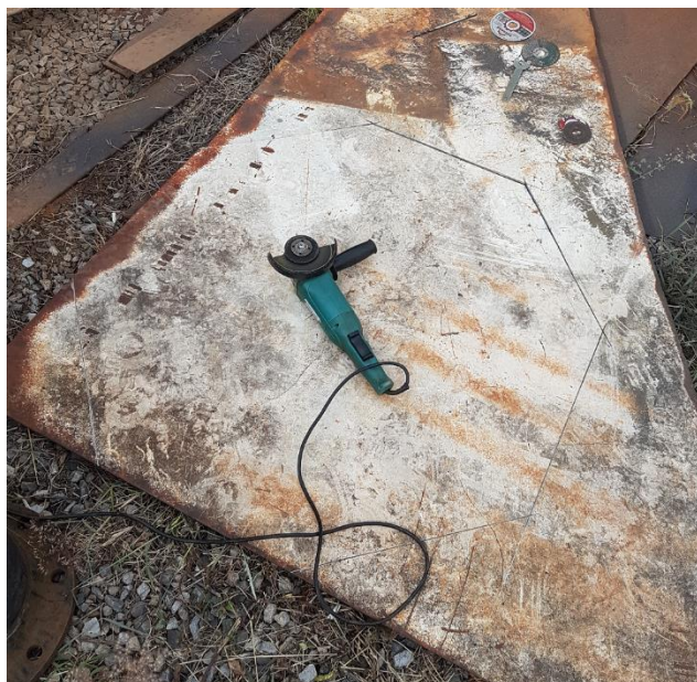
Figura 65 - Corte da chapa para construção da pista da bancada.
