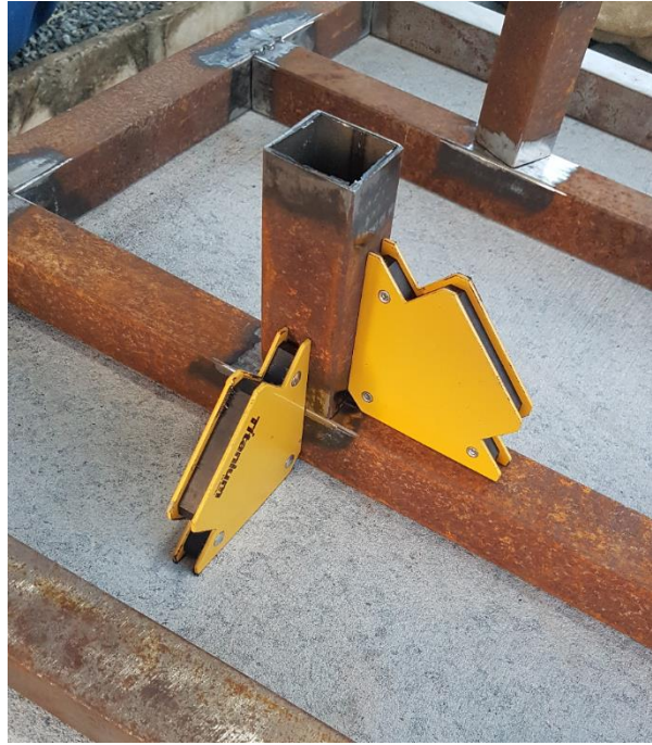
Figura 59 - Posicionamento dos tubos com auxílio de esquadros magnéticos.
