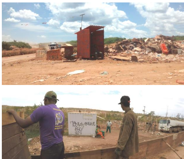
Fotografias 36 e 37. Primeiro, tenda localizada à beira do principal cruzamento do lixão; depois, container localizado na estrada que se encaminhava para o Maciço.
