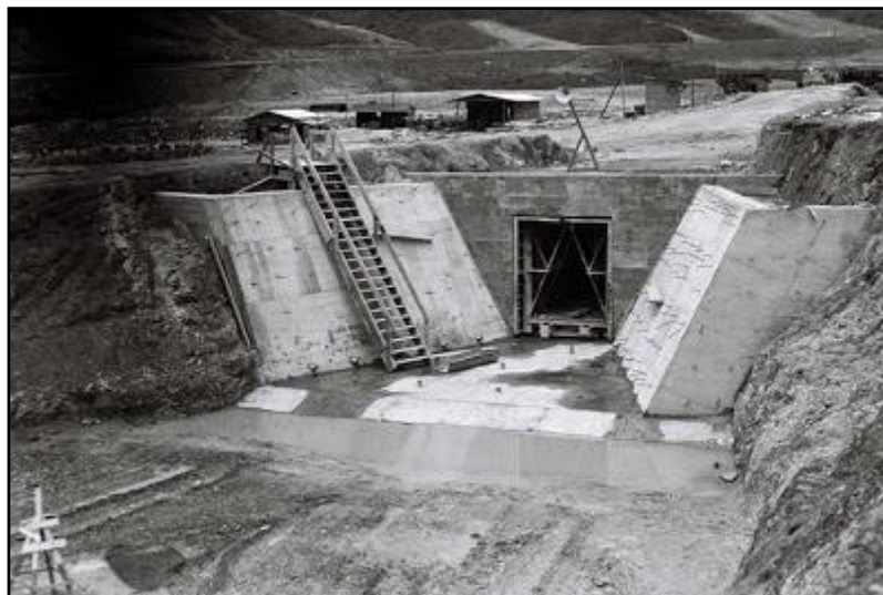
Foto 14: Construção da Barragem do Paranoá-DF (1959). Fonte: ARPDP.
