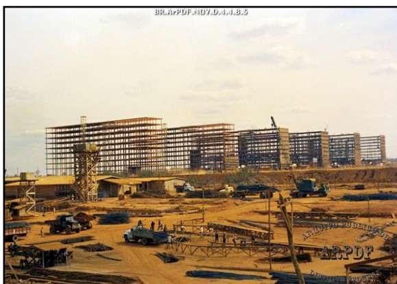
Fotos 6: Construção da Esplanada dos Ministérios (1956/1960). Fonte: APDF.
