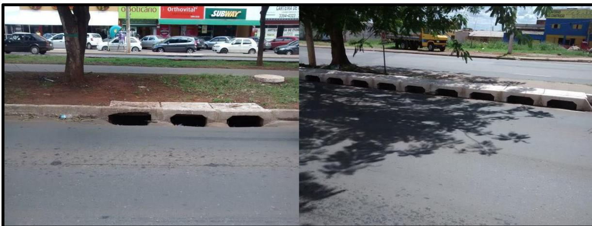
**Figura 10:** Bocas-de-lobo em diferentes pontos da av. Alagado.
