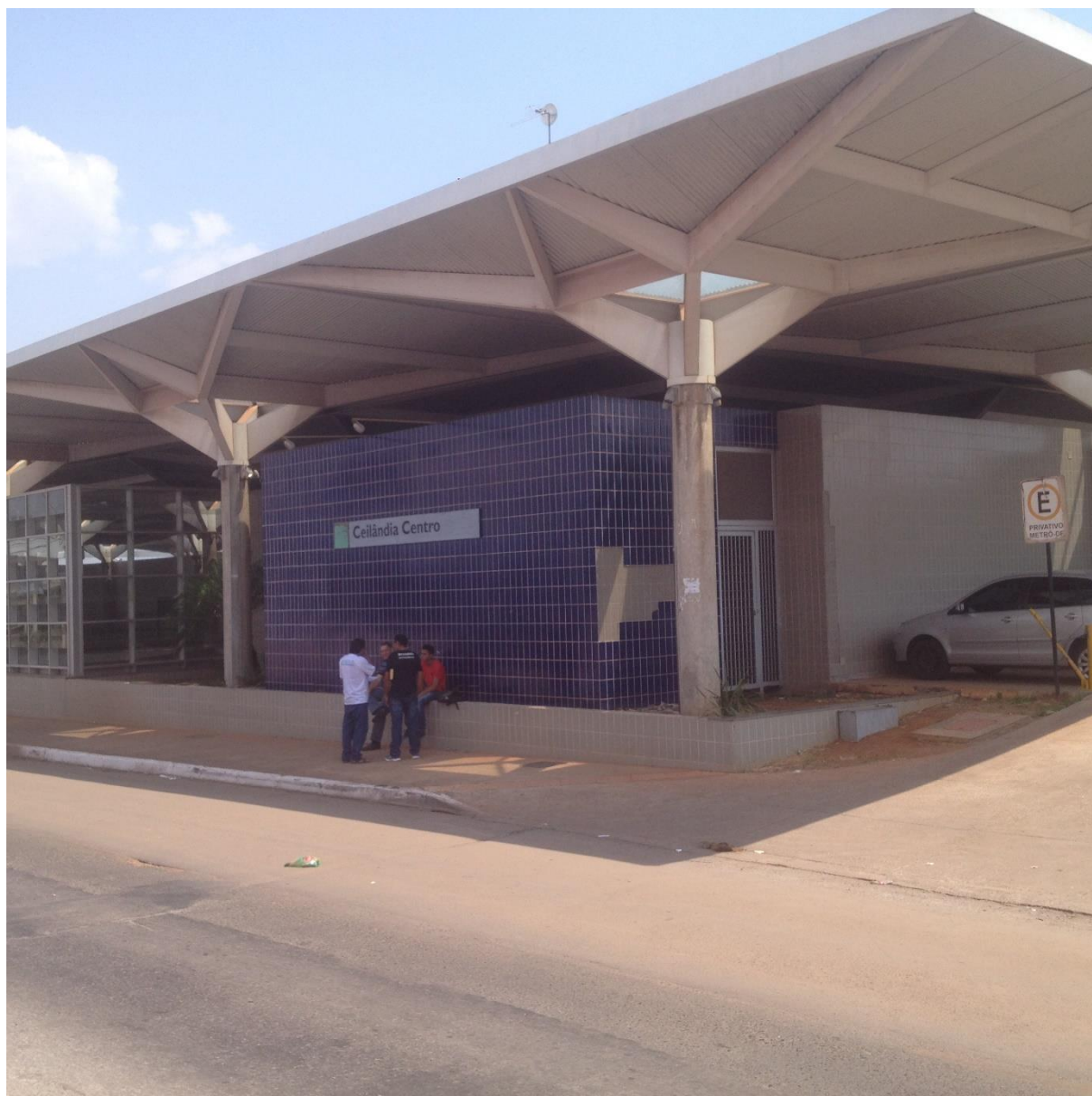
Figura 14 – Estação de Metrô – Ceilândia Centro
