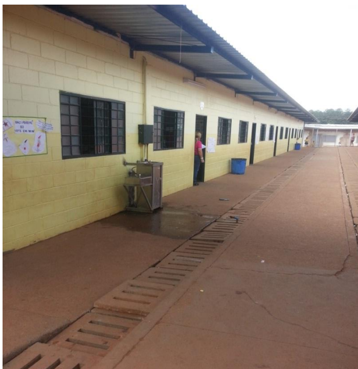
Figura 3 - Bloco de sala de aulas
