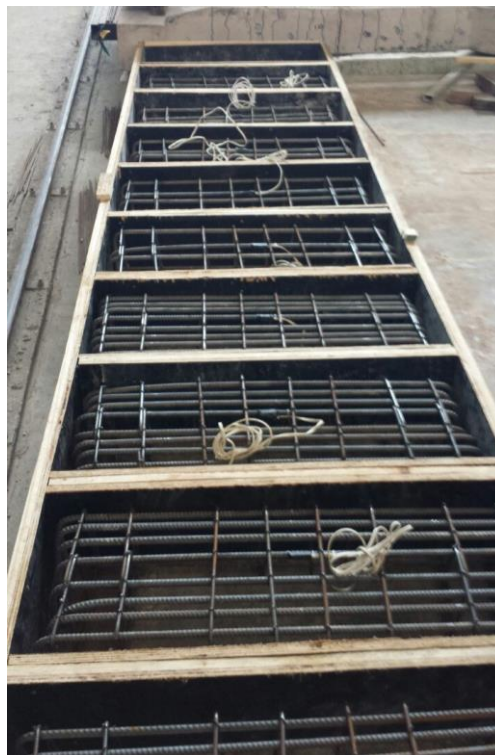
Figura 24 - Disposição das formas já armadas
