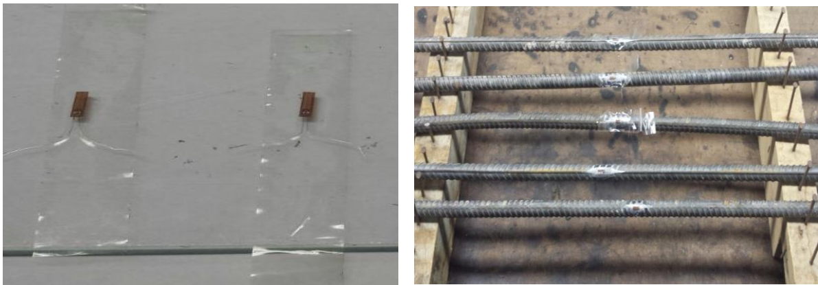
Figura 27 – Montagem do extensômetro
