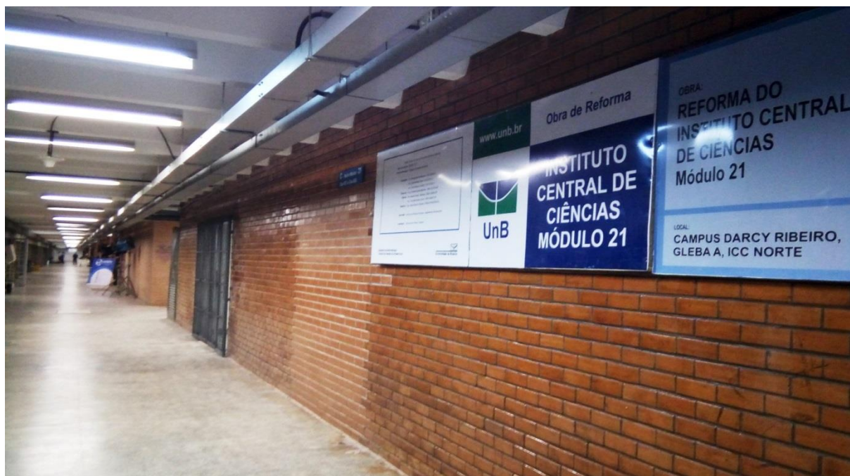
Figura 4.9 – Entrada do Módulo 21 (em reforma)
