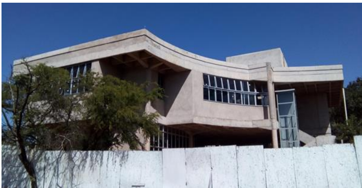
Figura 4.7 – Centro de Vivência (em construção)
