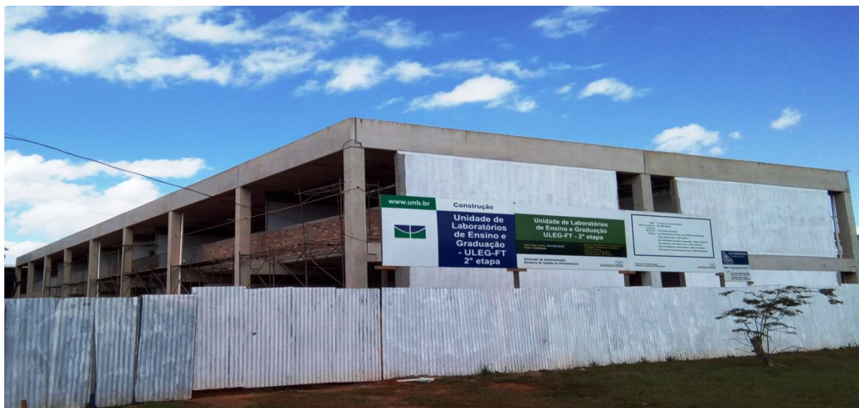
Figura 4.10 – Prédio da ULEG-FT (em construção)
