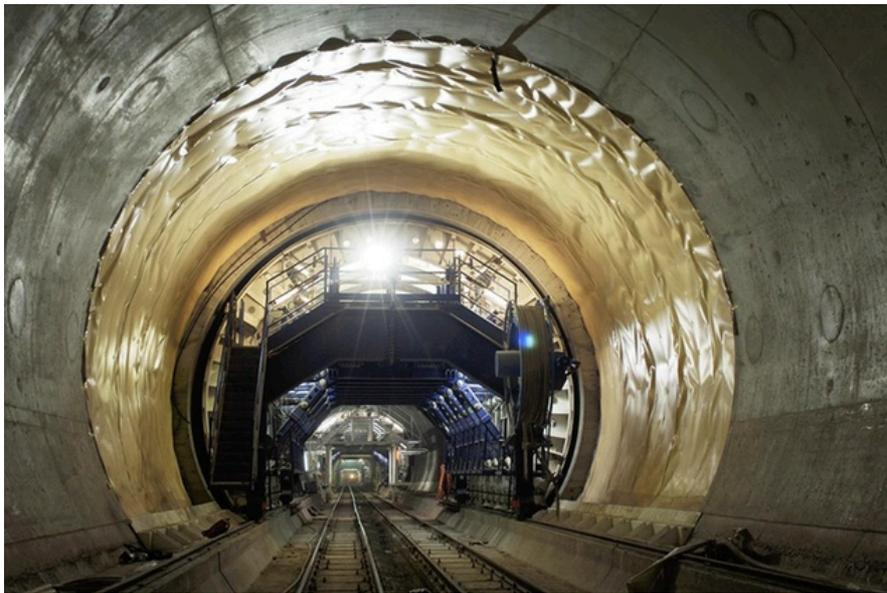
**Figura 2.5 - Cobertura impermeável instalada no túnel de São Gotardo.**
