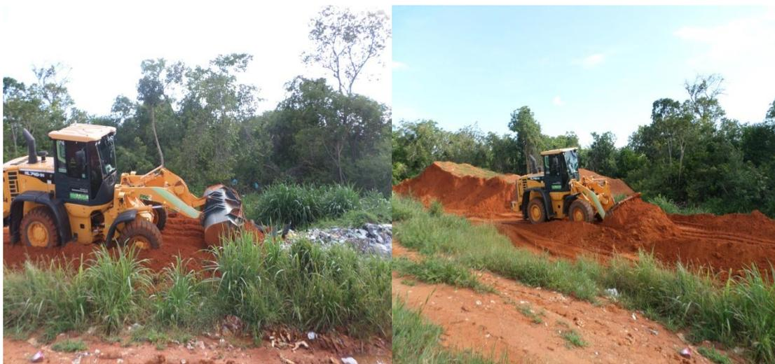
Figura 5: Recobrimento das valas sépticas.
