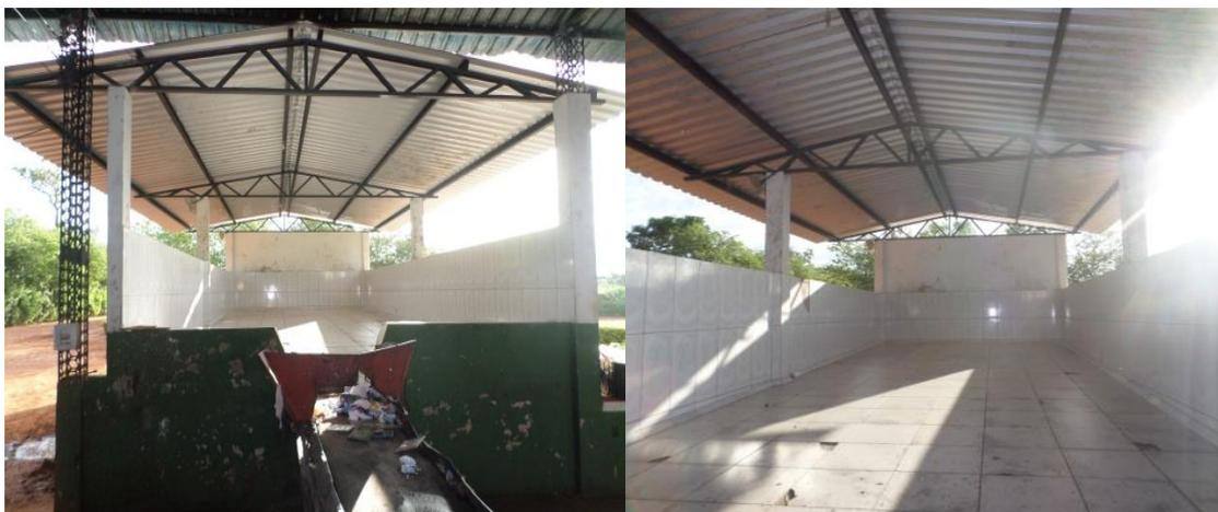
Figura 3: Receptor dos resíduos sólidos após a reforma e ampliação.
