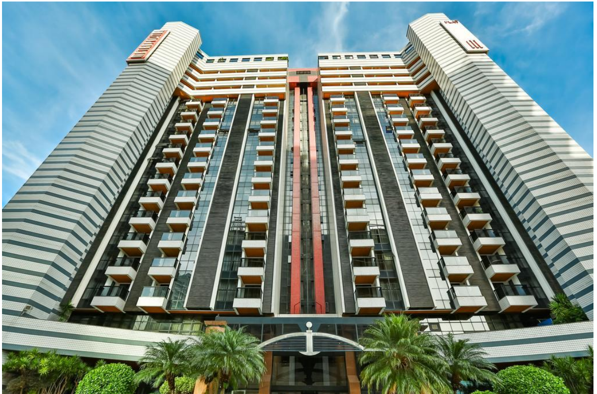
Figura 5: Vista da fachada do Hotel Metropolitan Flat
