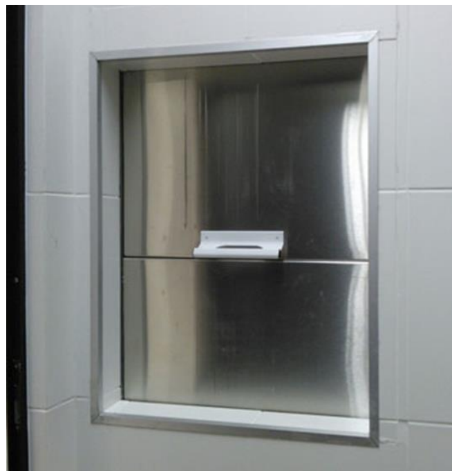
Figura 3. 11 - Monta-carga com porta bi-partida. Fonte: Empresa Portac ( http://www.portac.com.br/elevador-monta-carga.html ).
