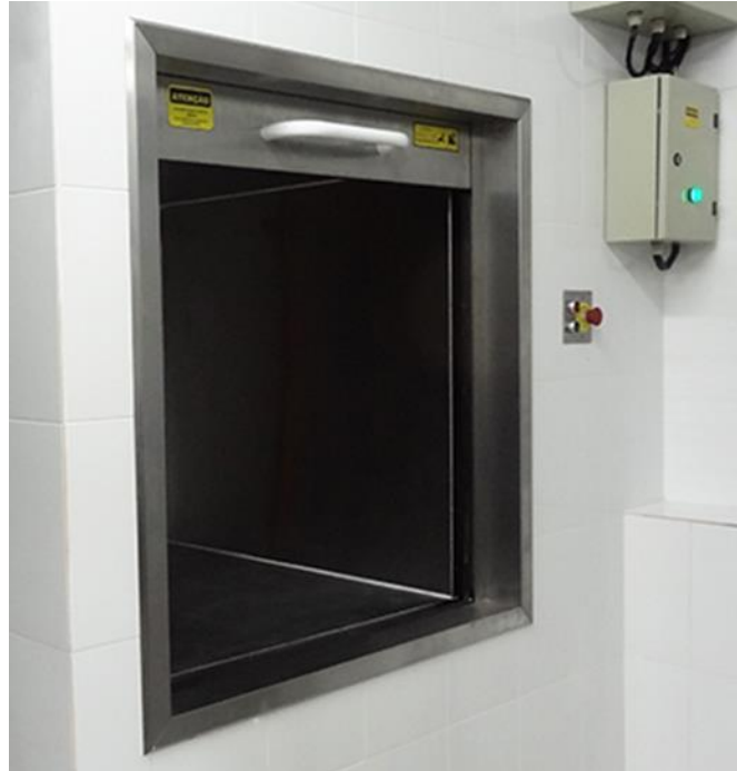
Figura 3. 10 - Monta-carga com porta do tipo corredeira vertical. Fonte: Empresa EMASTER Elevadores ( http://www.emasterelevadores.com.br/produtos/monta-cargas-auto-portante/ ).
