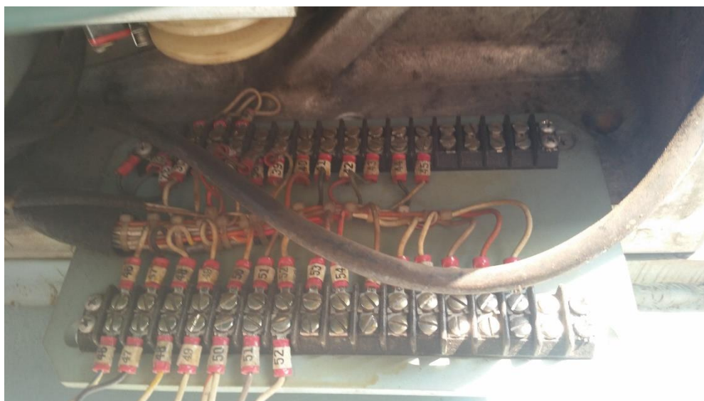
Figura 4.2: Conectores responsáveis pelos comandos do Posicionador
