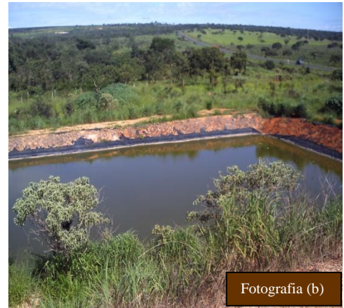
Figura 09: Célula do Aterro controlado já coberto, fotografia (a). Reservatório do chorume drenado das células, fotografia (b). Cidade Formosa – GO. Autor: Simone Silva da Fonseca.
