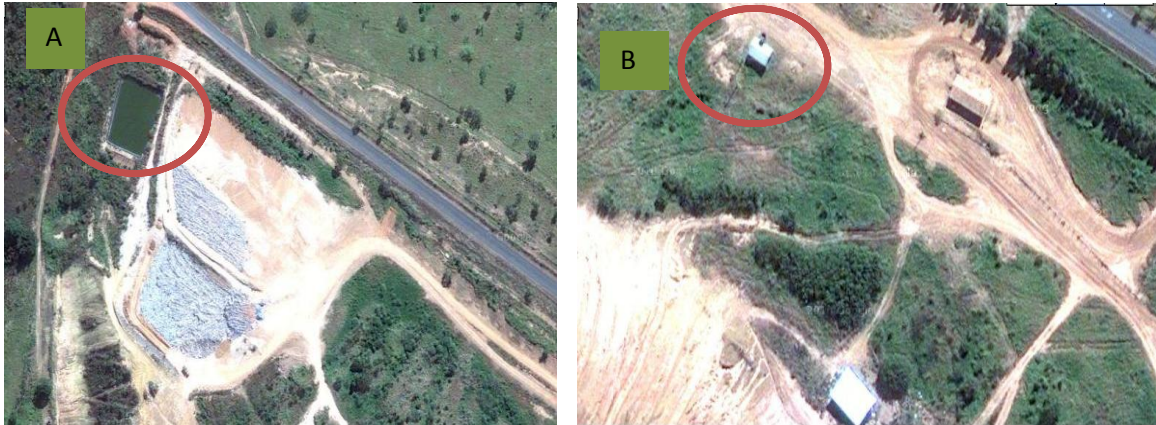
Figura 06: Vista por satélite do aterro controlado de Formosa- GO, (a) depósito do chorume, (b) casa de incineração desativada.
