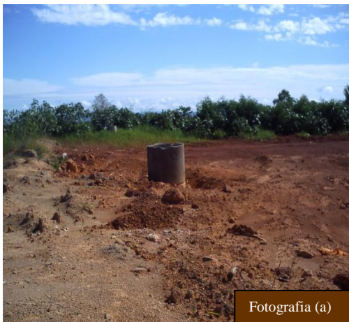
Figura 10: Célula fechada, com o lixo compactado no seu interior e com manilha que retira o metano produzido pelo lixo, fotografia (a). Célula aberta, sendo o lixo armazenado no seu interior, fotografia (b). Cidade de Formosa – GO. Autor: Simone Silva da Fonseca.
