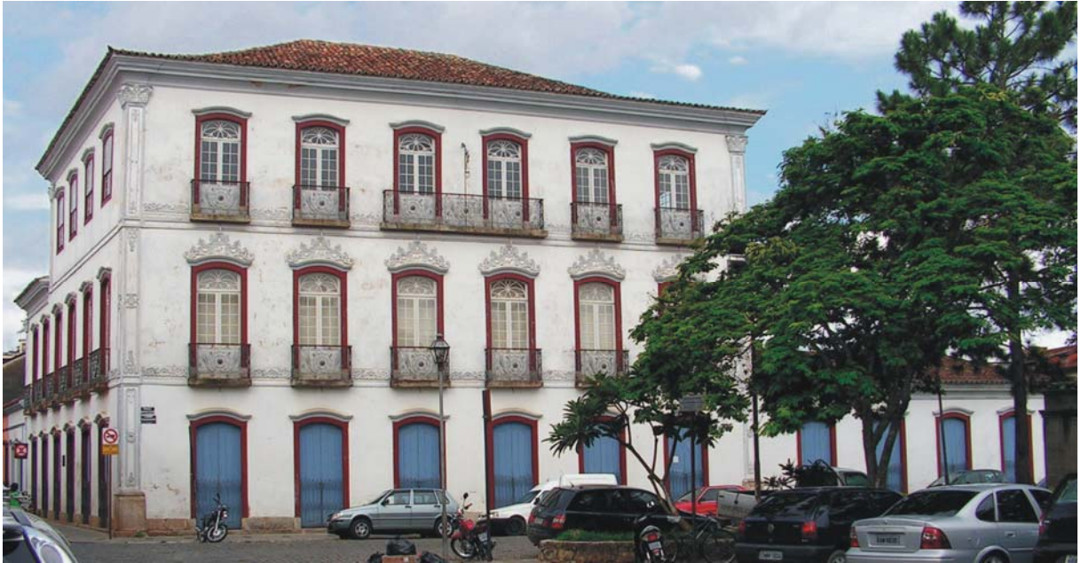
Figura 3: Casarão do Comendador atual Museu Regional – vista frontal a partir da praça Severiano de Resende
