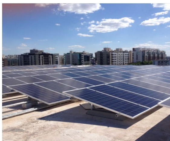
Figura 19 – Instalação dos painéis fotovoltaicos no prédio em análise
