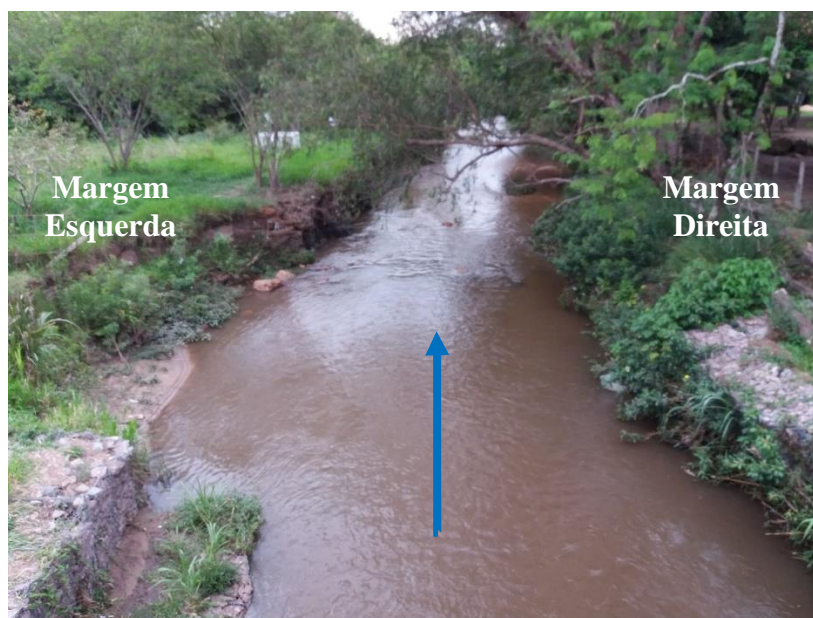
Figura 5.2 – Vista superior da ponte do trecho do rio Riacho Fundo
