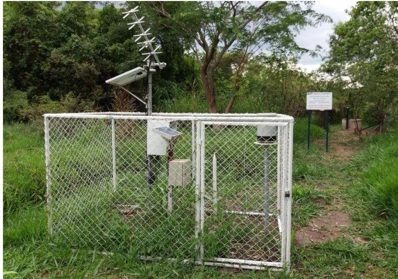
Figura 4.1 – Estação Fluviométrica Riacho Fundo Montante Zoológico
