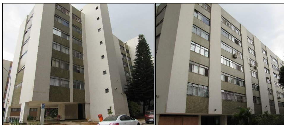
Figura 4.7 - Fotos das fachadas oeste (esquerda) e leste (direita) do edifício B.
