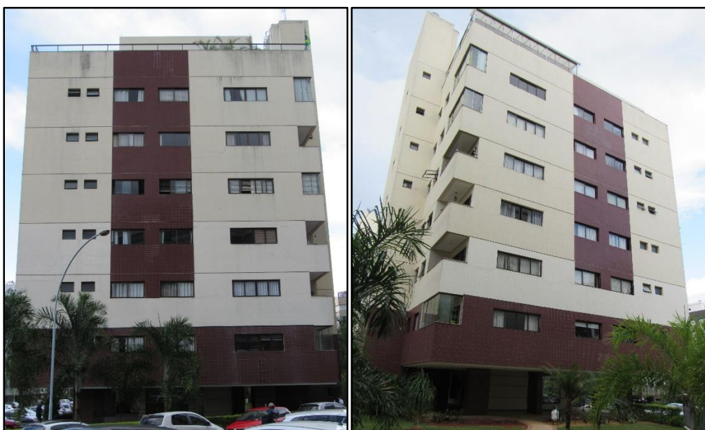
Figura 4.12 - Fotos das Empenas oeste (esquerda) e leste (direita) do edifício C.
