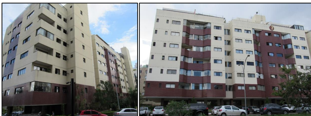
Figura 4.13 - Fotos das fachadas sul (esquerda) e norte (direita) do edifício C.
