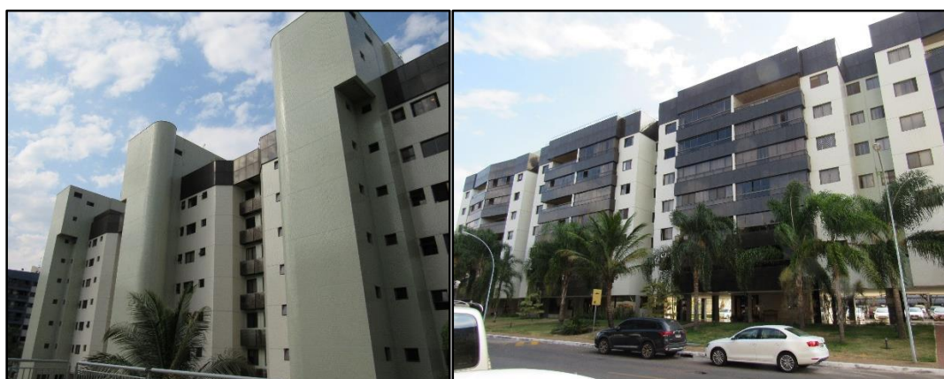
Figura 4.3- Fotos das fachadas oeste (esquerda) e leste (direita) do edifício A.
