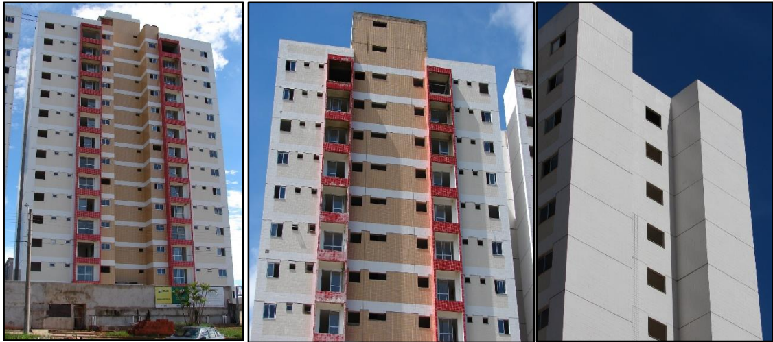
Figura 4.19 - Fotos das fachadas sul (esquerda), norte (centro) e empena leste (direita) do edifício E.
