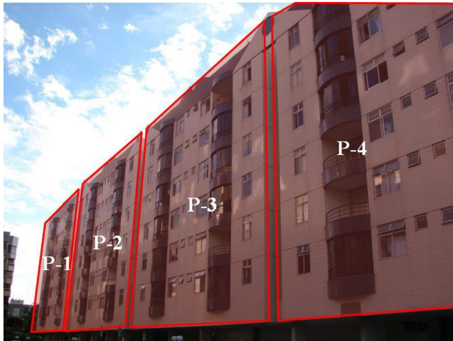
Figura 3.2 – Divisão da prumada de um edifício em quatro amostras (P1, P2, P3 e P4) entre as juntas de movimentação estrutural. (SILVA, 2014)
