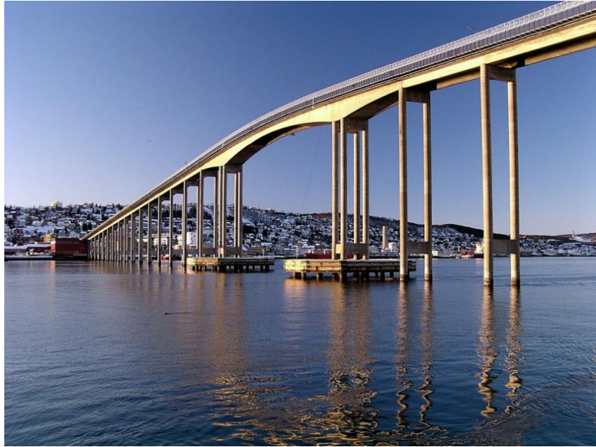
Figura 21 – Fotografia de 2006 da Ponte Tromso em Tromso, Noruega, e suas estacas de proteção.
