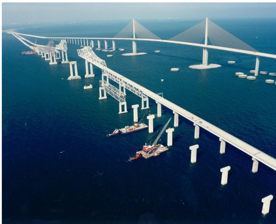
Figura 11 – A nova Sunshine Skyway Bridge ao lado da antiga.
