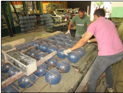
a) Concretagem das pré-lajes, dia 21/12/2015
