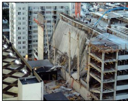
Figura 1.6 – Colapso parcial do edifício Tropicana Casino , em Atlantic City , EUA [https://failures.wikispaces.com]
