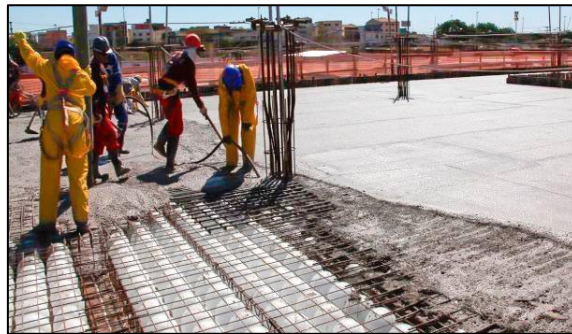
Figura 1.8 – Concretagem de uma laje BubbleDeck [página web da BubbleDeck Brasil no Facebook]
