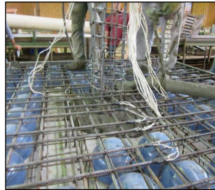
b) Concretagem das lajes, dia 19/01/2016
