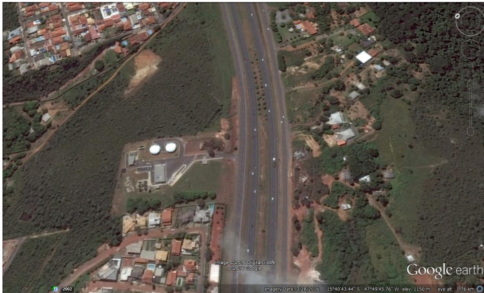
Figura 4.3. Trecho do Km 3,5 ao 4,5 aéreo.
