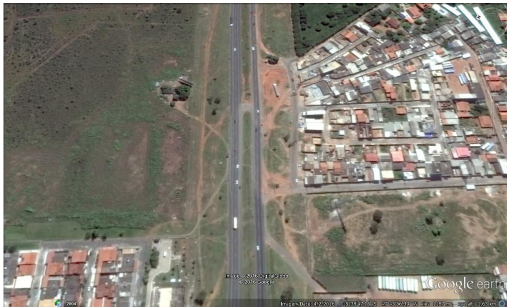
Figura 4.11. Trecho do Km 10,8 ao 11,8 aéreo.
