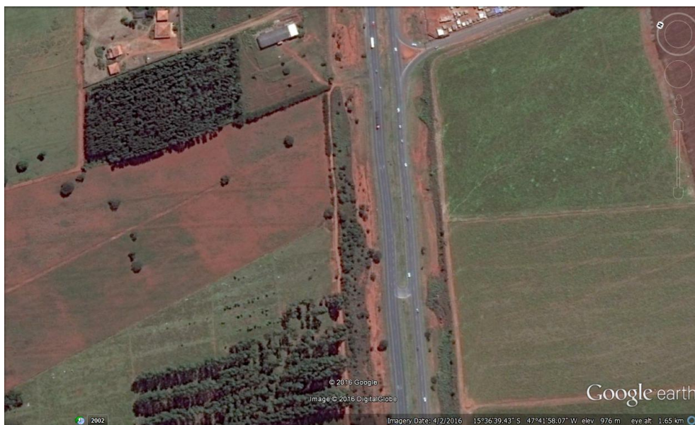
Figura 4.5. Trecho do Km 15,8 ao 18,8 aéreo.
