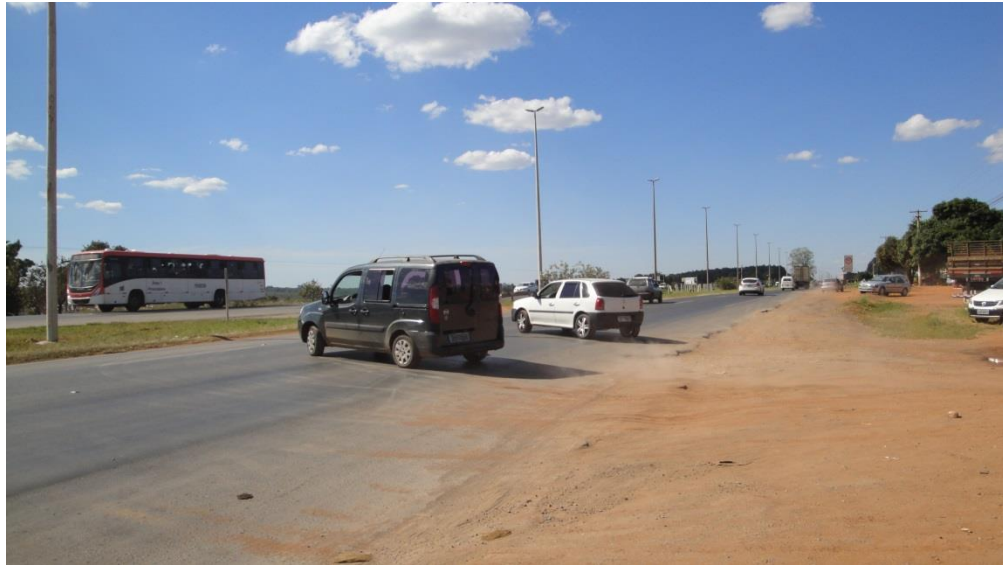
Figura 4.10. Trecho do Km 10,8 ao 11,8 in loco.
