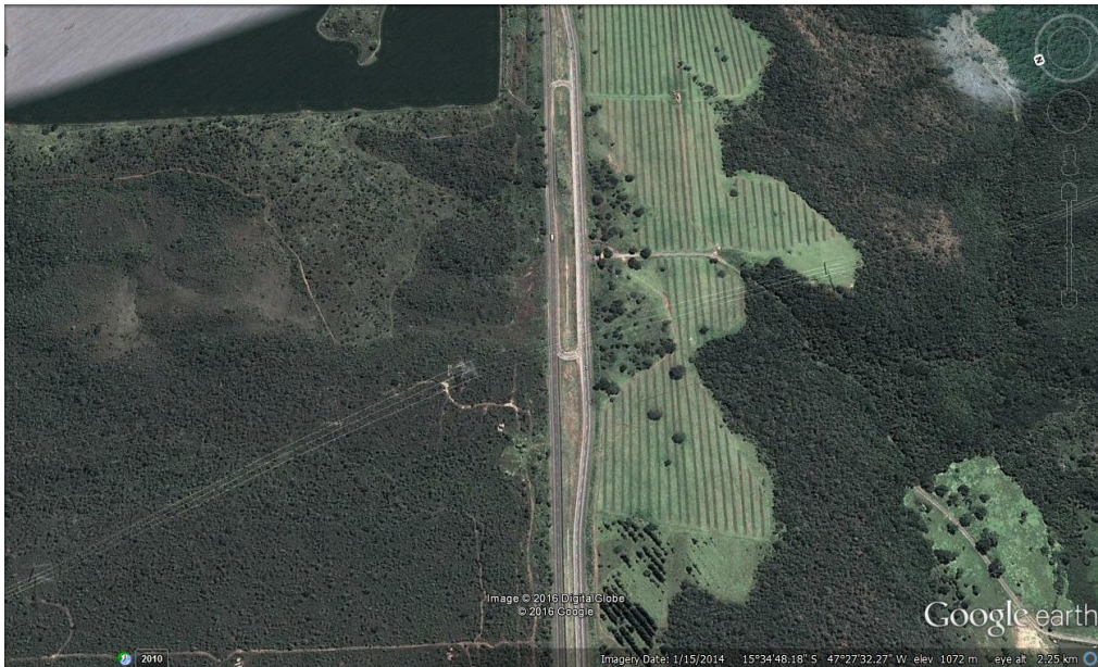
Figura 4.7. Trecho do Km 46,8 ao 47,8 aéreo.
