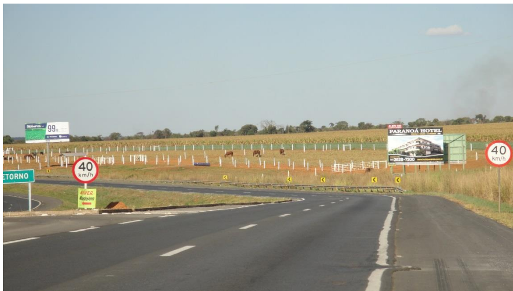
Figura 4.8. Trecho do Km 56,1 ao 57,1 in loco .
