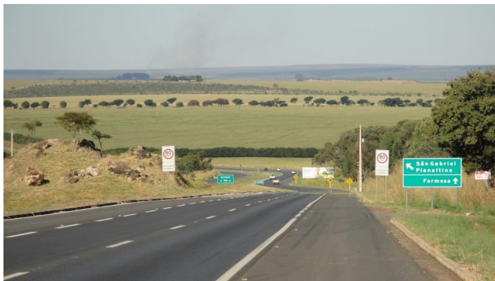
Figura 4.6. Trecho do Km 46,8 ao 47,8 in loco .
