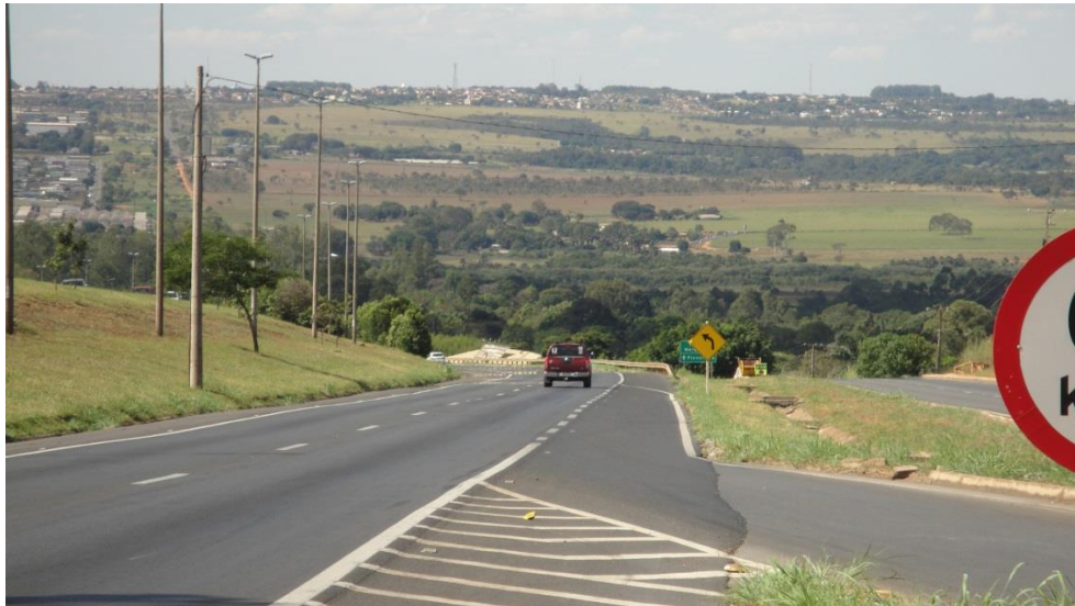
Figura 4.2. Trecho do Km 3,5 ao 4,5 in loco .
