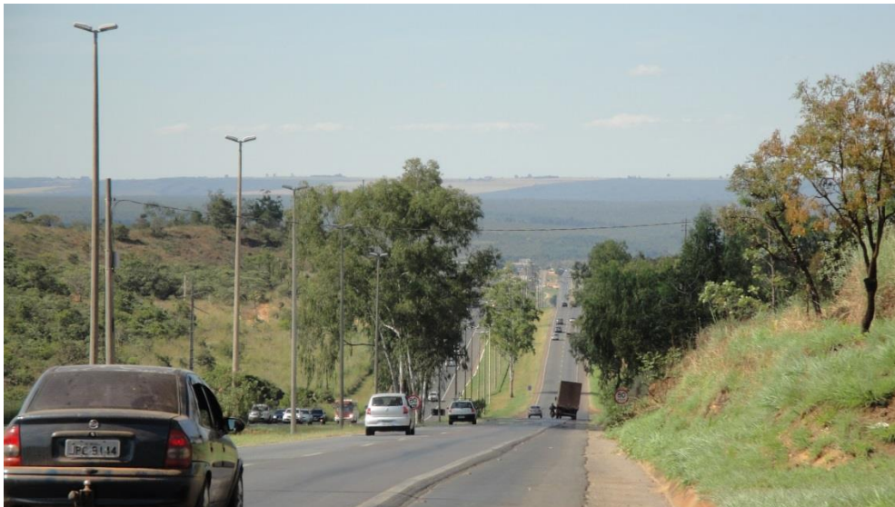
Figura 4.4. Trecho do Km 15,8 ao 18,8 in loco .
