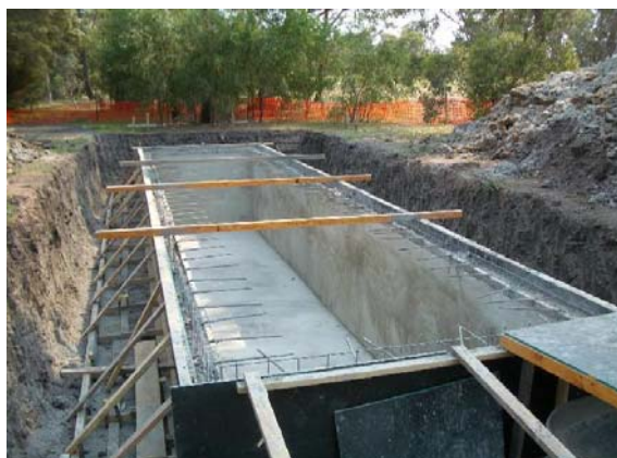
Figura 3-21 – Reservatório de água em concreto armado. Fonte: Mitchcon (2016).
