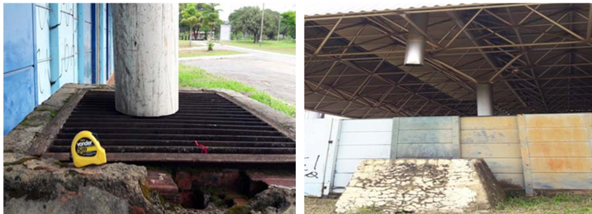
Figura 5-4 – Detalhes da grade e da caixa de concreto ligada ao dispositivo de coleta.
