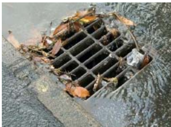
Figura 3-6 – Grade de proteção de dispositivo de coleta no nível do solo. Fonte: Handerson Water Utility , 2016.
