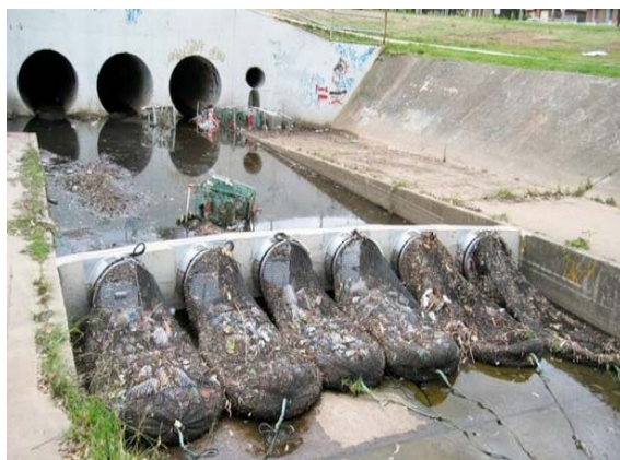
Figura 3-12 – Dispositivo de remoção de sólidos na forma de rede. Fonte: Storm Water Systems , 2016.
