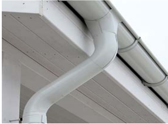
Figura 3-3 – Condutor e calha vertical. Fonte: AEC Web, 2016.
