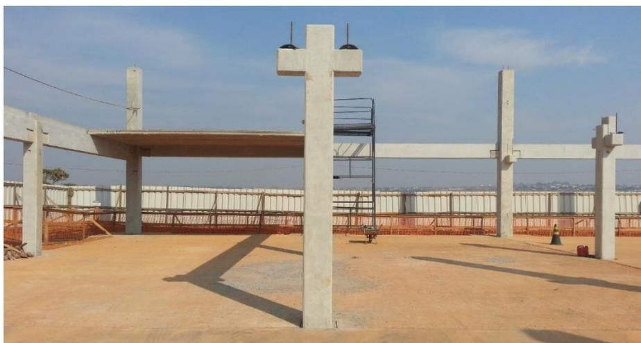
Figura 3-5 - Disposição geral dos elementos na obra. Pilares com consolos, pinos e apoios de elastômero. Lajes apoiadas nas vigas e vigas com dentes Gerber apoiadas nos pilares. (Foto do autor)
