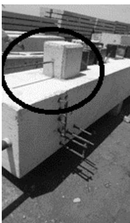
Figura 2-8- Consolo com pino proeminente (chumbador) destacado pela área circulada (Fábrica Tecron – Luziânia).
