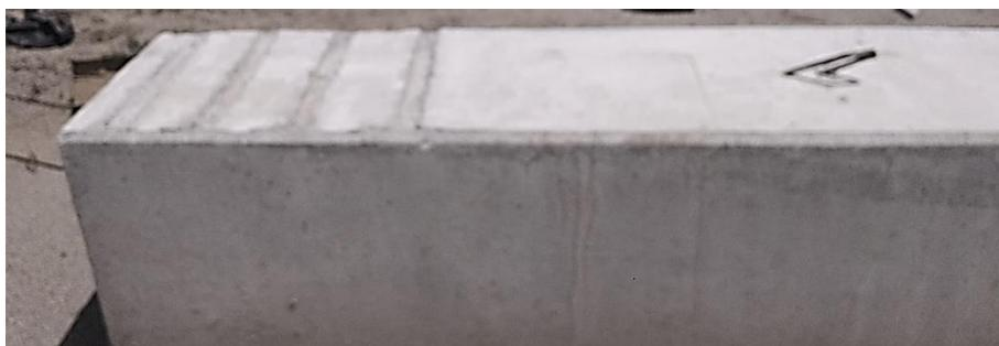
Figura 2-13- Ranhuras de base em pilar de fundação (Fábrica Tecron – Luziânia).
