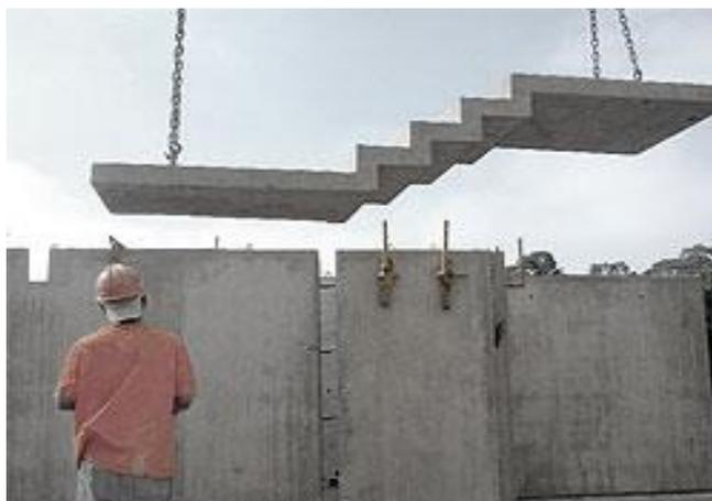
Figura 2-1- Escada e parede pré-moldadas. Observar o içamento para posterior encaixe da escada em sua posição final de utilização. (Cimento Itambé, 2008).
