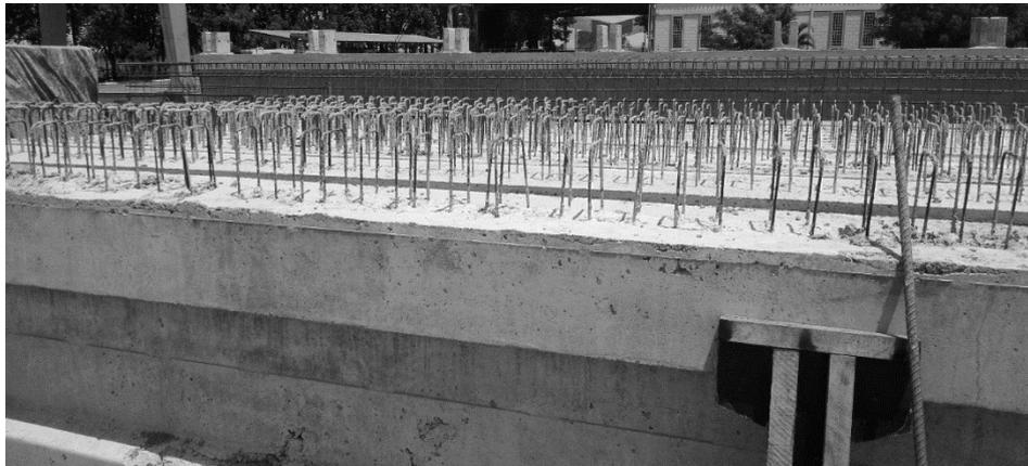
Figura 2-19- Vigas de seção I com armação exposta para posterior consolidação da união das lajes com as vigas (Fábrica Tecron – Luziânia).
