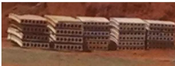
Figura 3-4 - Armazenamento em canteiro das lajes alveolares pré-moldadas com contra-flecha. (Foto do autor)
