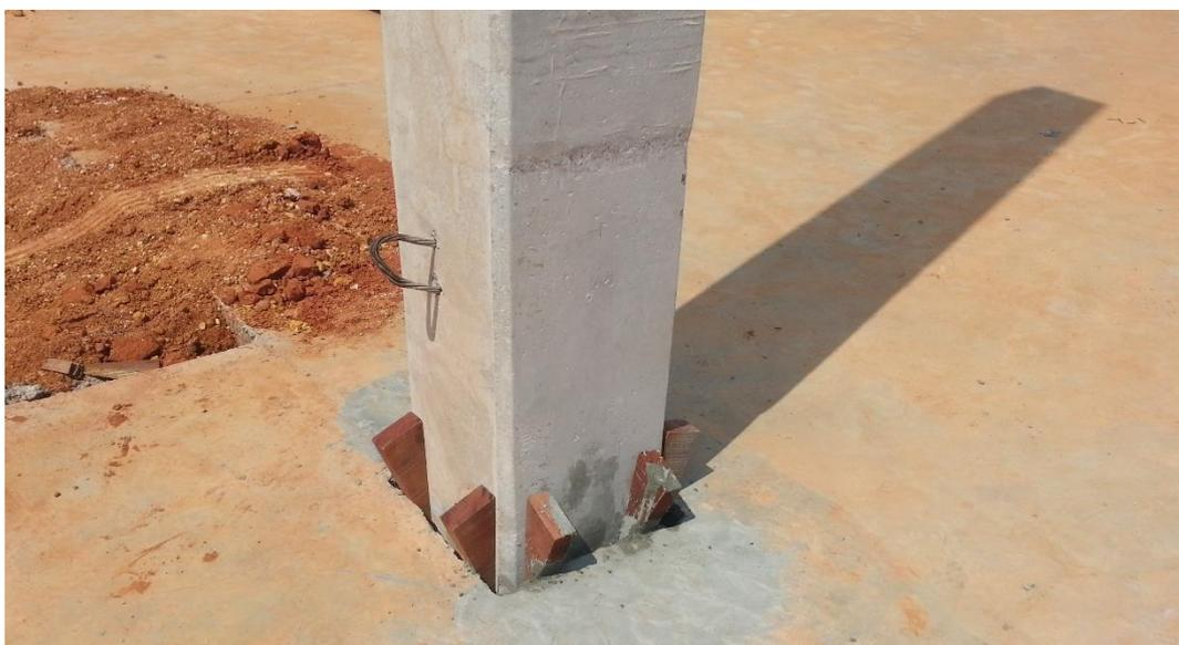
Figura 3-8 - Pilar com inserção no cálice de fundação e preenchimento do espaço vazio com graute. Uso de cunhas de madeira para centralização do pilar até completo endurecimento do graute. (Foto do autor)
