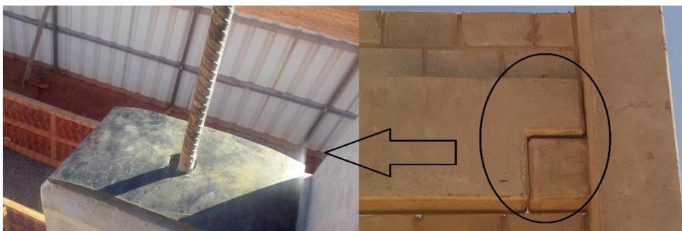
Figura 3-6 - Apoio do dente Gerber no consolo com pino e almofada de elastômero. (Foto do autor)
