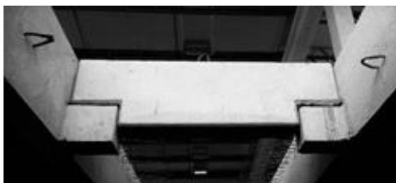
Figura 2-15- Ligação dente Gerber-consolo (Galpão Multiuso – Brasília).
