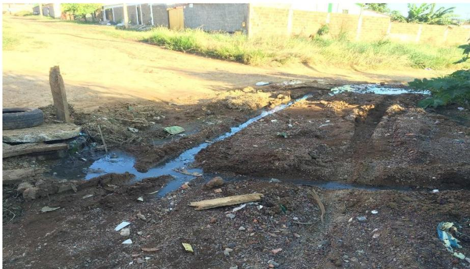
Figura 5.24 – Foto de vazamento de rede de esgoto próximo à nascente 4. Fonte: Arquivo Pessoal (2016).
