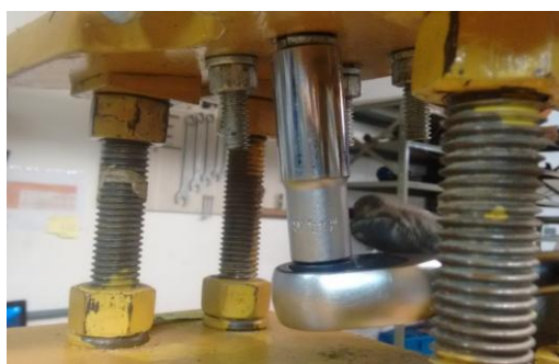
Figura 4.19 - Fixação do grampo de suspensão.
