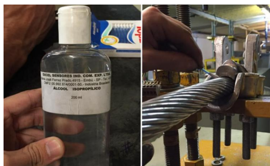
Figura 4.22 - Limpeza do local onde serão colados os extensômetros.
