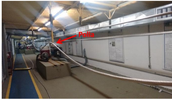
Figura 4.12 - Conductor estendido apoiado nas polias ao longo do vão.
