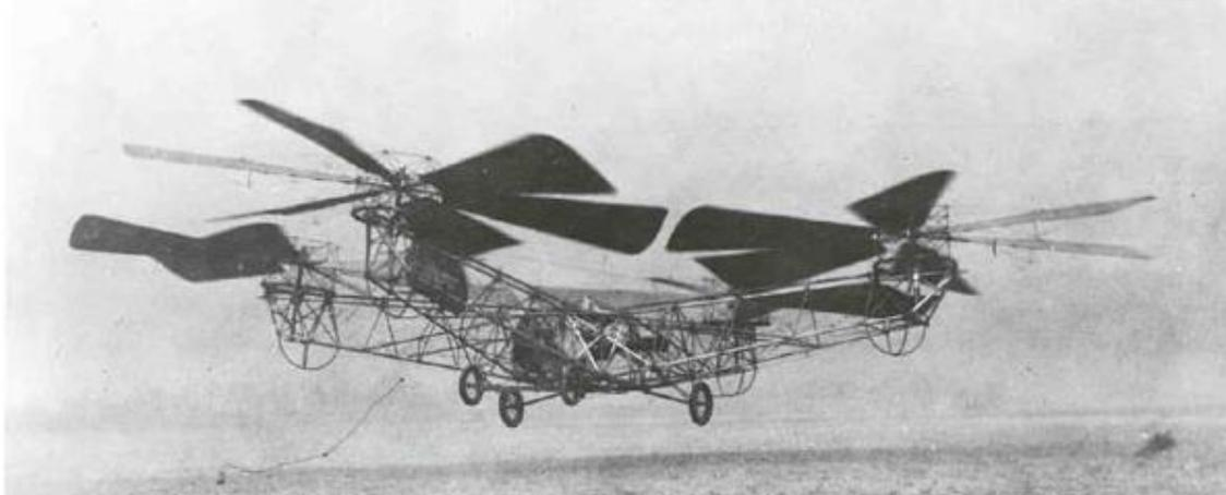
**Figura 1.2** - De Bothezat helicóptero.<sup>1</sup>
