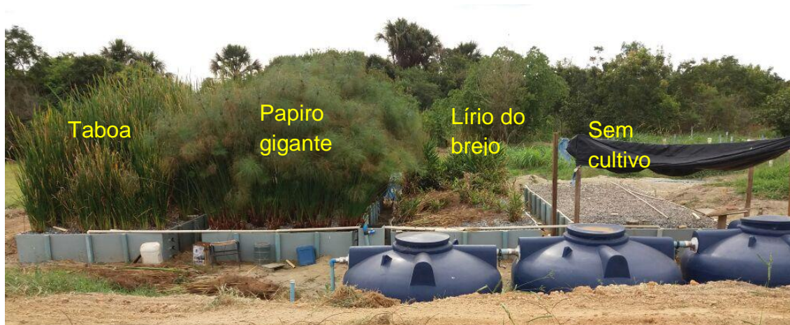
Figura 3. Disposição dos leitos e visualização das macrófitas após 390 dias após o transplântio.
