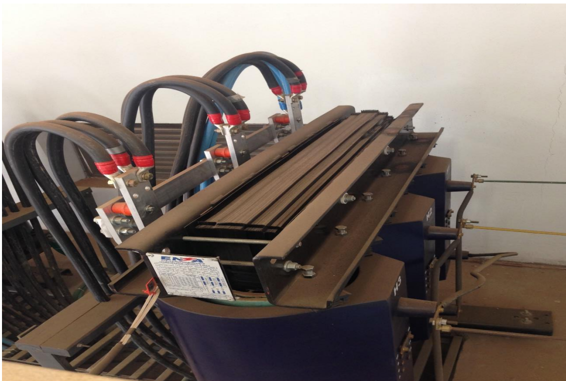
Figura AP3.1: Subestação da FACE [1]
