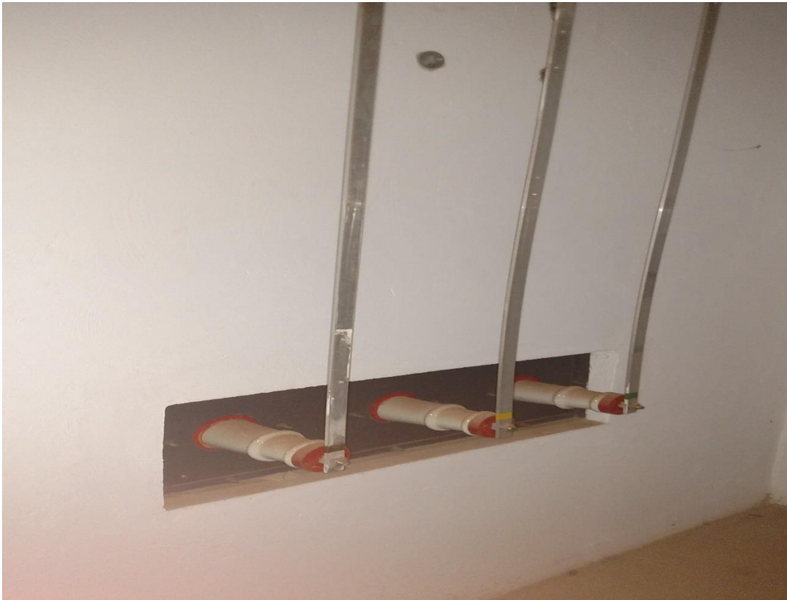
Figura AP2.5: Subestação da Reitoria [5]
