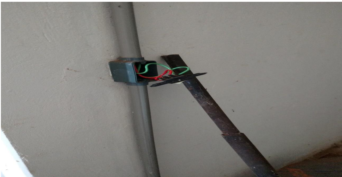
Figura AP2.6: Subestação da Reitoria [6]
