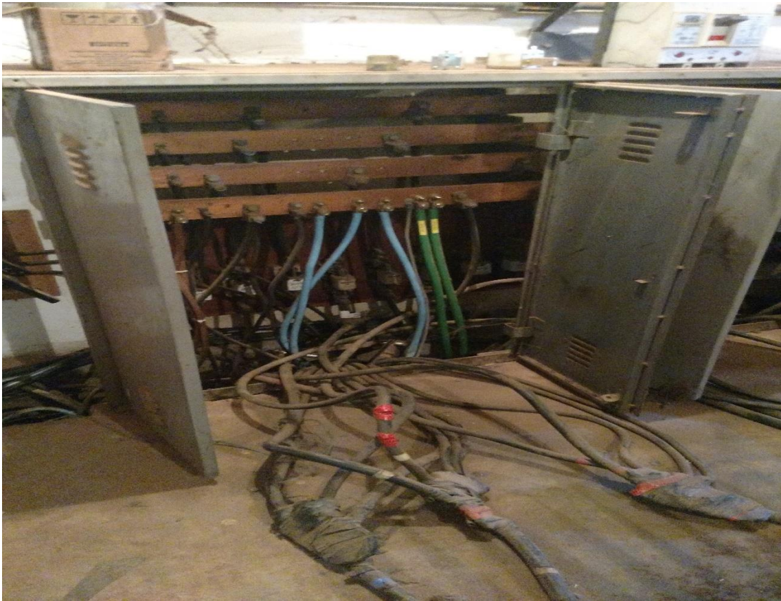
Figura AP1.3: Subestação do ICC Norte [3]
