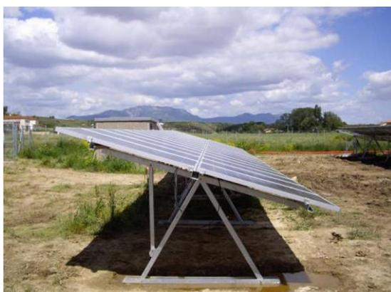
Figura 2.13 – *Ilustração de um sistema fotovoltaico de estrutura fixa com inclinação variável*
