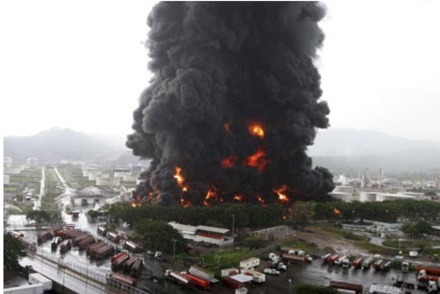
Figura 2.9 – incêndio provocado por queda de raio em refinaria de petróleo[13].
