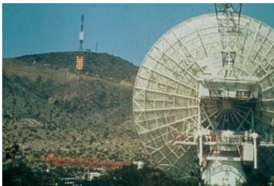
Figura 4.3 : Teste de transmissão de energia via microondas em Goldstone, Estados Unidos [29]
