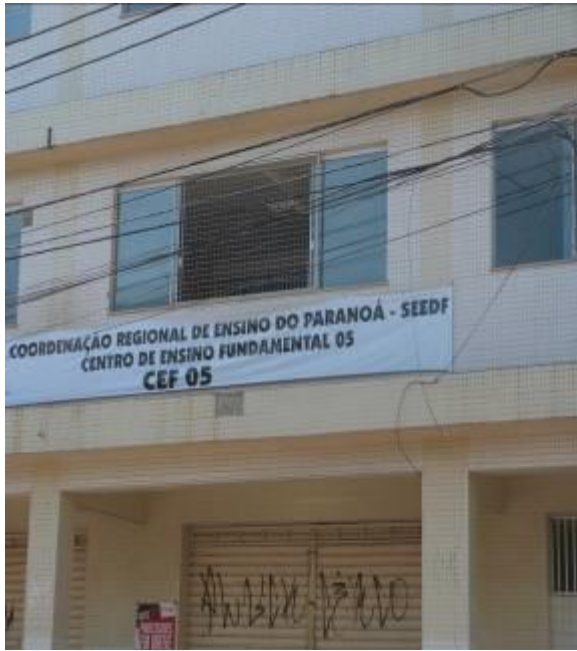
Imagem 1 Fachada do prédio do CEF 05 do Paranoá
