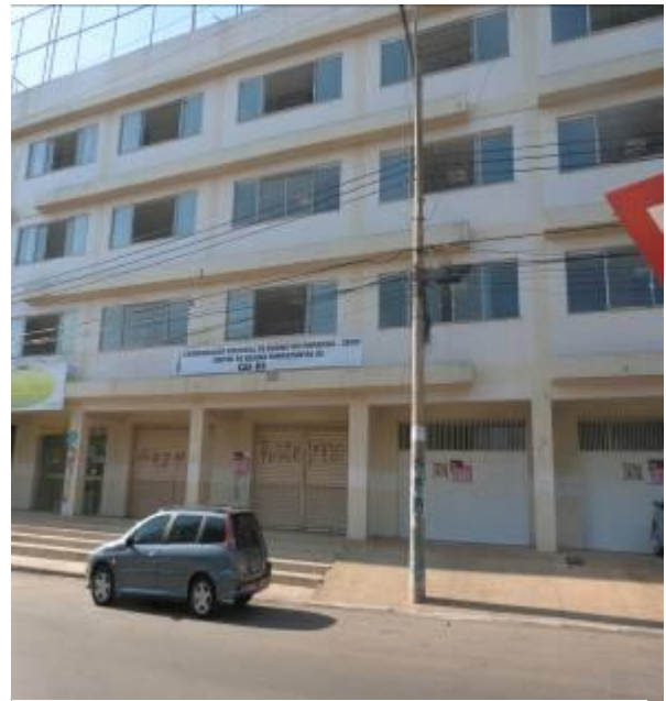
Imagem 2 Fachada do prédio do CEF 05 do Paranoá
